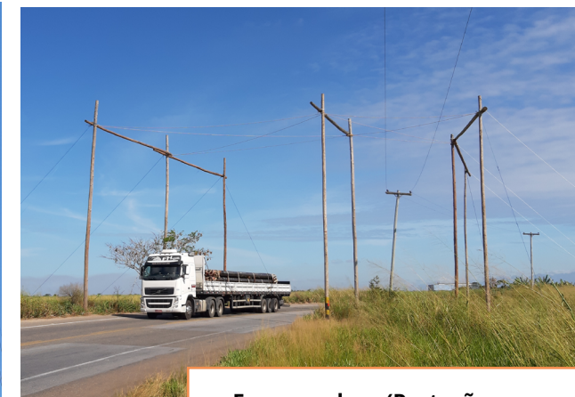
Empancadura (Proteção para passagem de cabos elétricos)
