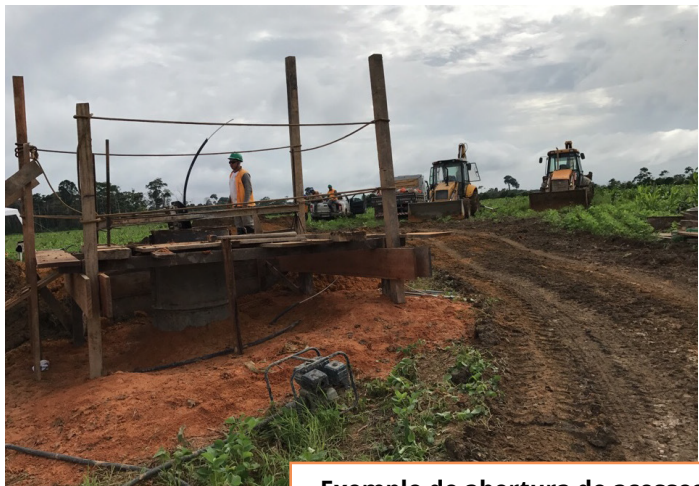
Exemplo de abertura de acessos
