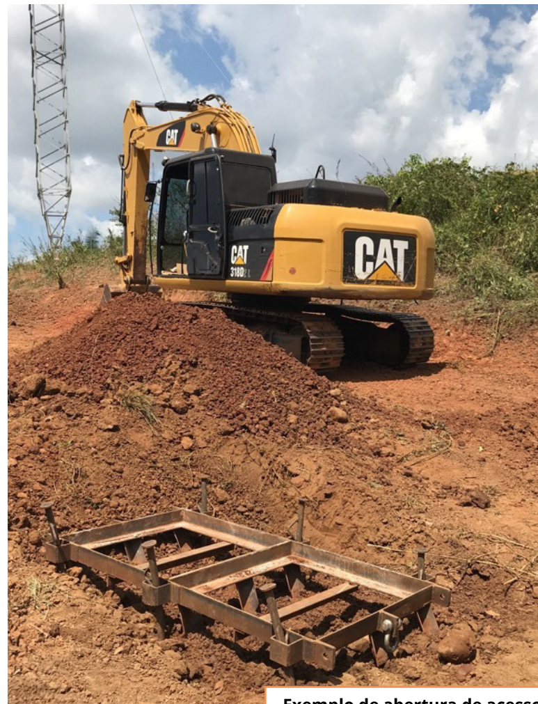
Exemplo de abertura de acessos
