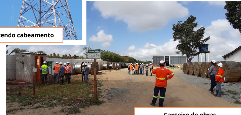
Canteiro de obras
