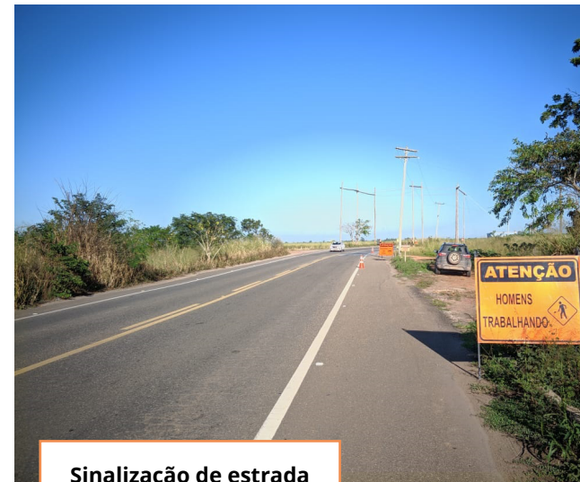
Sinalização de estrada durante obra
