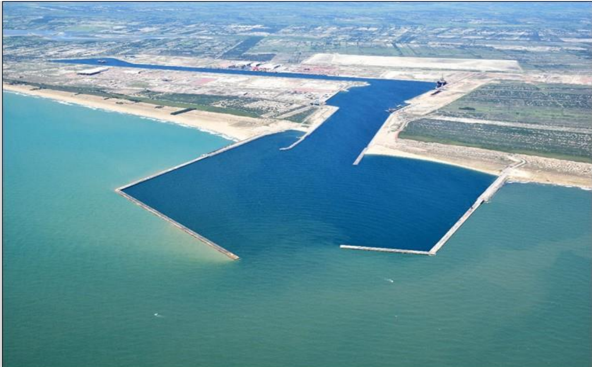
Foto da instalação
