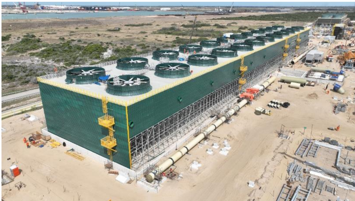
Figura 3-4: Torre de Resfriamento - UTE GNA II.
