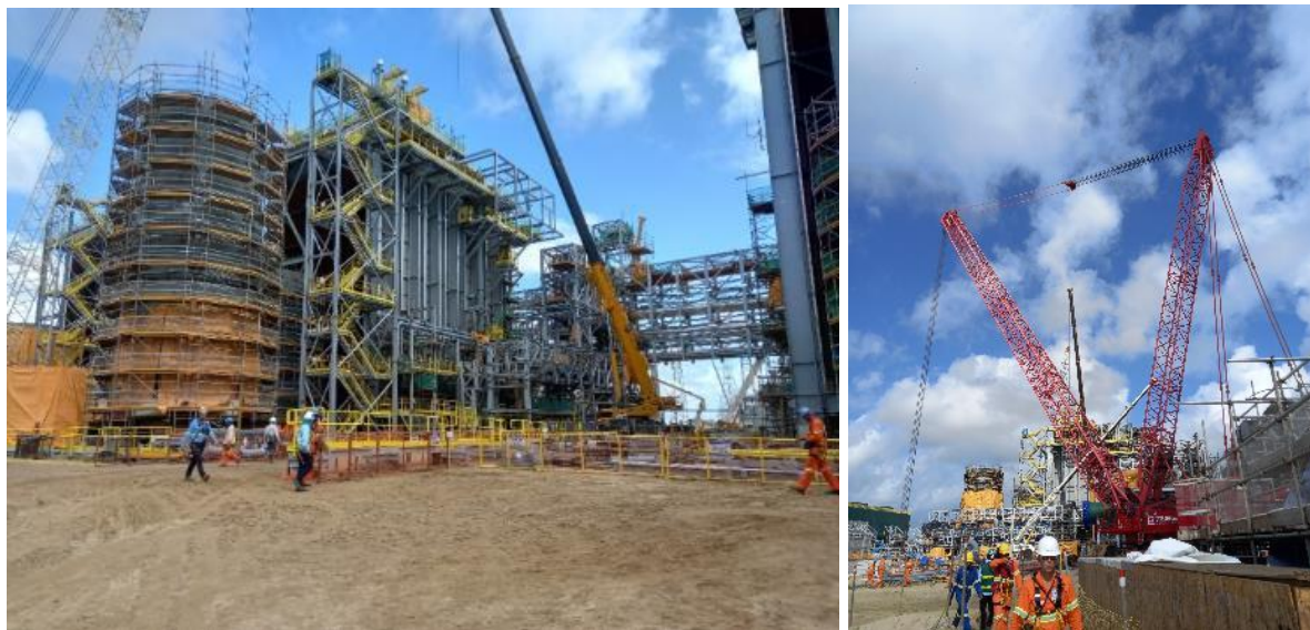
Figura 6-13: Vista das estruturas industriais em instalação.
