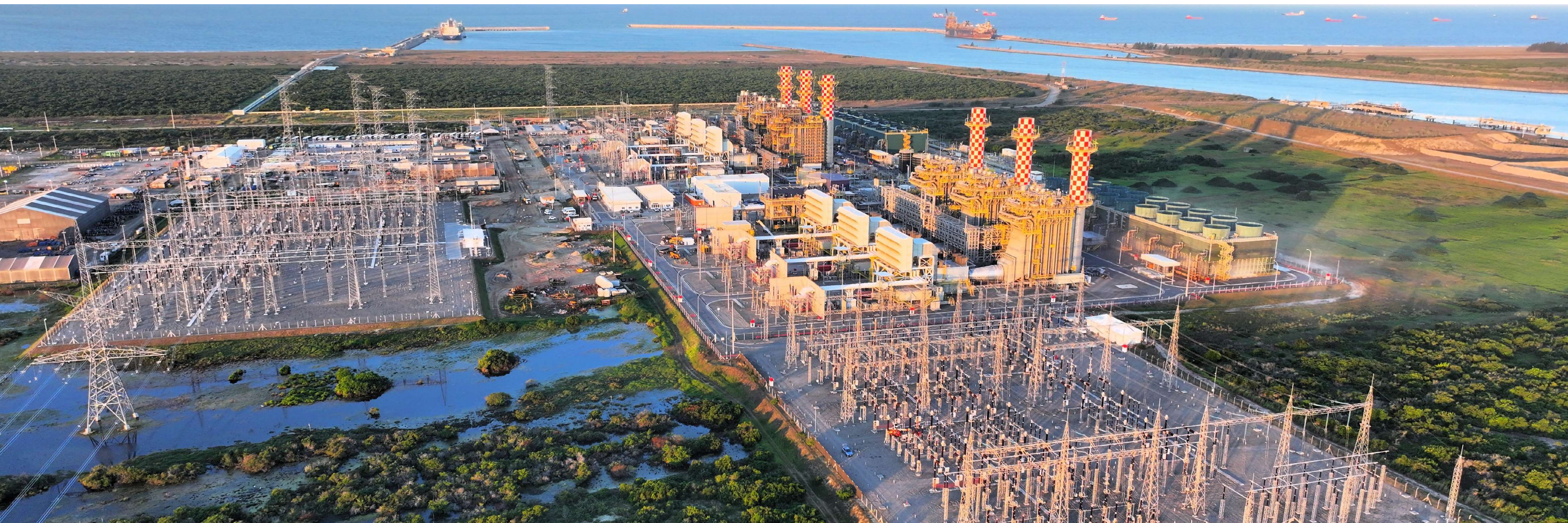
Imagem aérea do Complexo Termelétrico a Gás Natural e Linhas de Transmissão da GNA. FONTE: ACERVO GNA.
