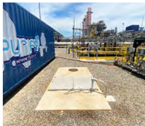
Caixa separadora de água e óleo instalada em área da UTE GNA II.
