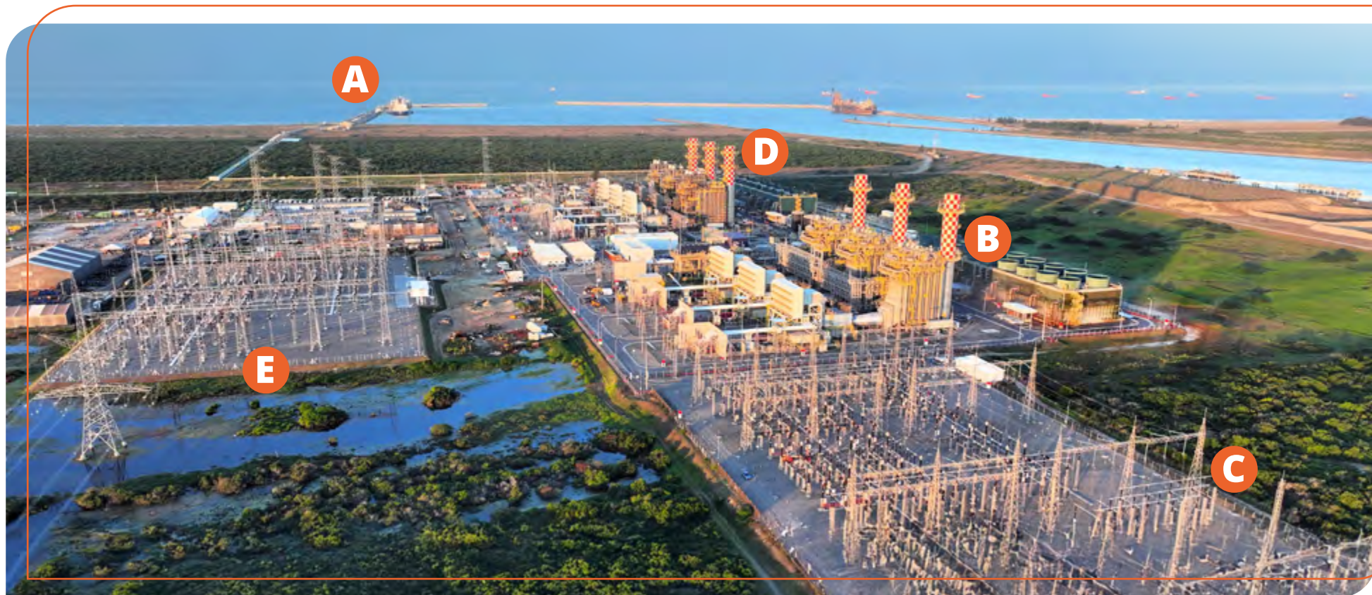
Imagem aérea do Parque Termelétrico a Gás da GNA, destacando:
